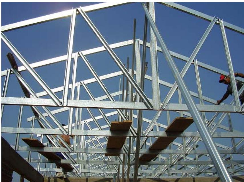
Es importante mencionar que hasta los 8 metros de luz y pendiente de faldones de 30°, separación entre cabriadas de 60 cm, las cabriadas realizadas con perfiles STEEL FRAME® PGC 100 x 0,9, con cubiertas livianas o pesadas, correctamente rigidizadas resisten las combinaciones de cargas permanentes, nieve y viento de todas las regiones del país.
