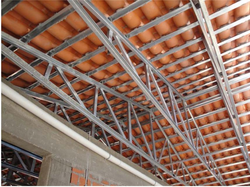
Como puede observarse en las fotografías, existe absoluta compatibilidad entre este tipo de cubiertas y la construcción tradicional, debiendo verificarse la transmisión de esfuerzos entre las cabriadas y los muros de apoyo, a través de fijaciones adecuadas.
